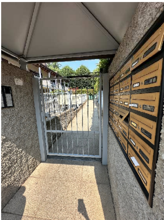
4. Dettaglio del cancelletto pedonale su strada.
