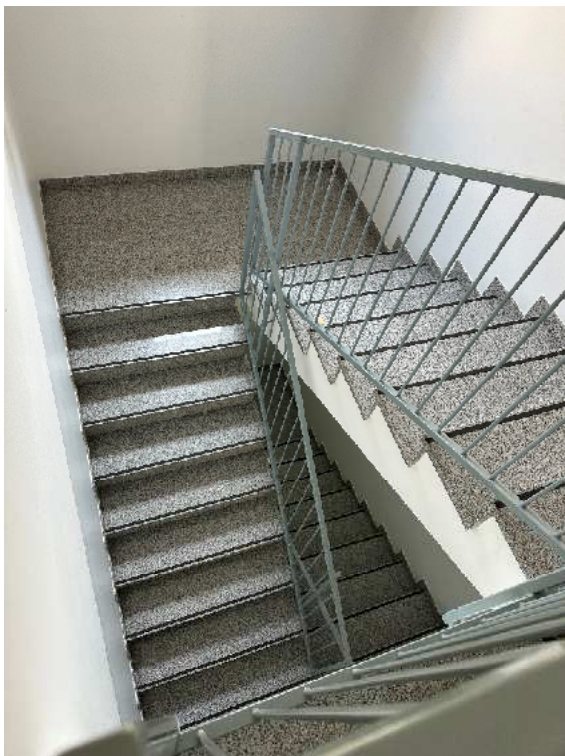
6. Dettaglio della scala condominiale.
